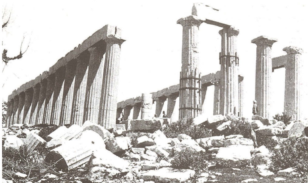
Εικ. 53: Ο ναός από νότιοδυτικά, περί το 1891. Στη φωτογραφία διακρίνεται και η περιίδεση με στεφάνες των δύο κίωνων της νότιας όψης.
