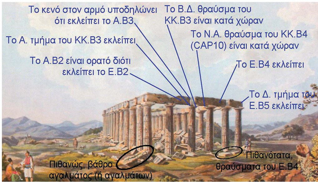
Εικ. 47: Το σχέδιο της Εικόνας 32 με σχόλια περί της κατάστασης διατήρησης των κιονόκρανων και των επιστυλίων της βόρειας όψης του μνημείου.
