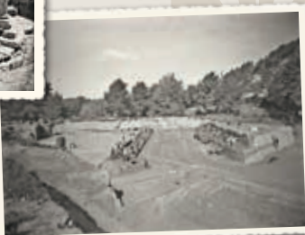
Στην ανασκαφή του Σταδίου χρησιμοποιήθηκαν βαγονέτα τύπου Decauville για την απομάκρυνση του τεράστιου όγκου χωμάτων.
